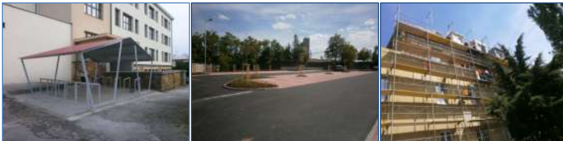
Kolostavy u ZŠ Žitomířská, parkoviště v ul. Klučovská, zateplení budovy pavilonu G nemocnice Český Brod
