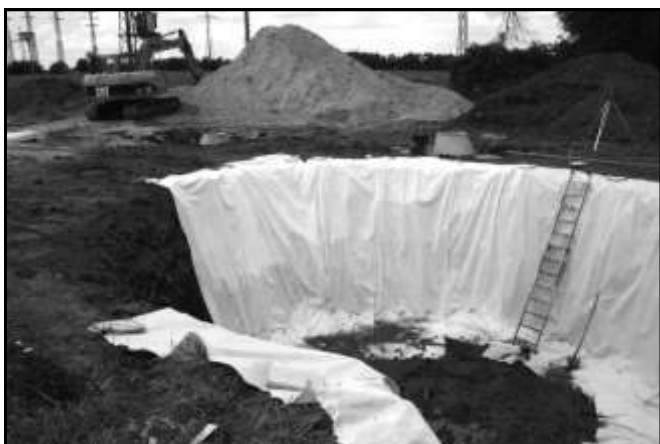
Výkopové práce pro novou svozovou jímku
