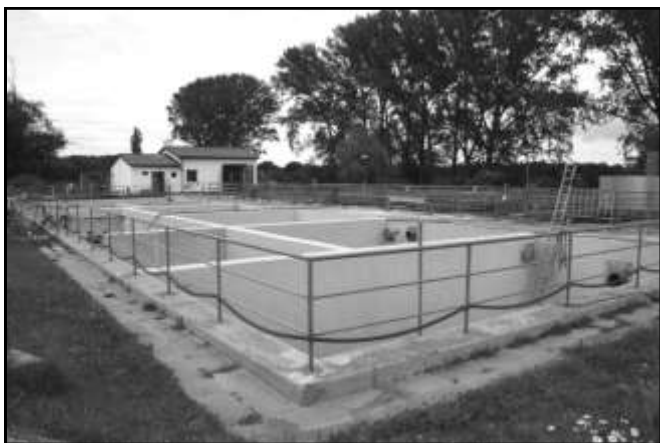
Sanační práce na původních uskladňovacích a nitrifikačních nádržích
