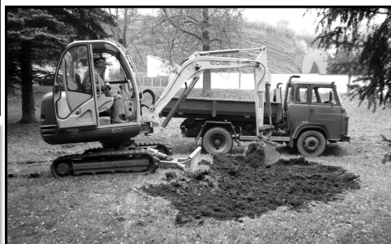
Výkopové práce na „fitku“
