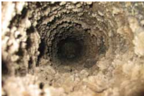
zanesený kouřovod
