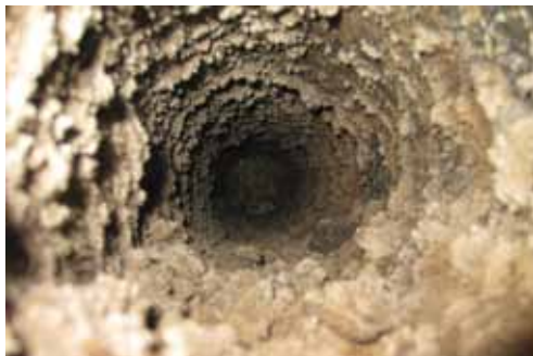
zanesený kouřovod
