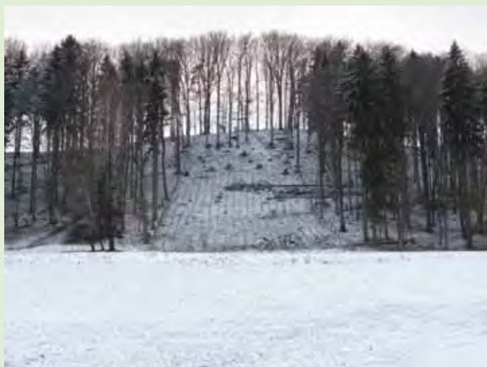
Obrázek 23: I když je násek v souladu se zákonem veden v šíři ne delší než délka okolních stromů, a i když je správně ponechána bučina na větrem namáhané horní straně svahu, přesto, i vlivem příliš blízké vzdálenosti dalšího náseku vpravo, bude jako vývrat padat při očekávané větší rychlosti větru vichřice více stromů než doposud právě u těchto naráz odlesněných ploch. Stromy rozbily dopadem nejen část nové výsadby, ale i oplocení, což umožnilo okus stromů zvěří. Přejítí na výběrný způsob těžby s přirozeným zmlazením lesa bude dobré pro ekologii i ekonomiku. Zima 2017-18, les města Teplic n. Metují, Kaplanka (v mapách chybně jako Libeňská stráž).
