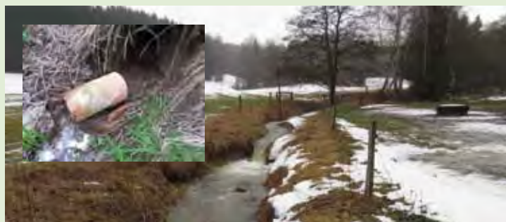
Obrázek 6: Tok Hrnčířského potoka na úrovni Svatého kopečku (100 m nad Kapličkou). Při přívalovém dešti či rychlém tání vody urychlená narovnáním toku a žlabovkami působí již pár set metrů pod pramenem boční i dnovou erozi. Zde voda dokonce už žlabovky vytrhla ze dna a každým rokem se potok o kousek prohlubuje. Tím se víc a víc vysušuje niva. Proto v těchto místech svou pouť voda často končí – do hlavního toku už se nedostane. Jediným řešením je zmenšení profilu toku na jednoletou vodu zvednutím výšky dna do původní výšky a vytvoření meandrů (zátáček), které zpomalí energii toku. Tedy návrat k přírodě blízkému stavu, který pak nevyžaduje skoro žádnou další údržbu. Jaro 2017.
